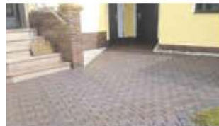
... und nach unserer Steinsanierung
