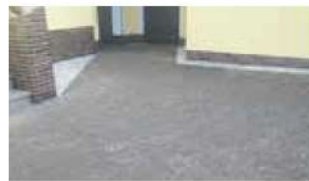
Die gepflasterte Fläche vor ...
