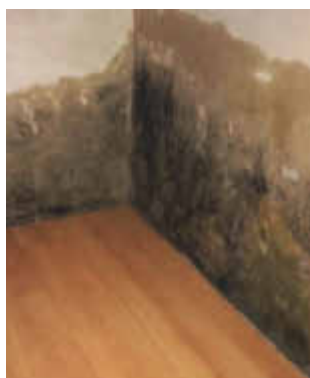
defekte Horizontalsperre
