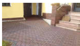
... und nach unserer Steinsanierung
