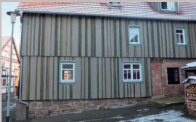
Farbige Deckleistenschalung
