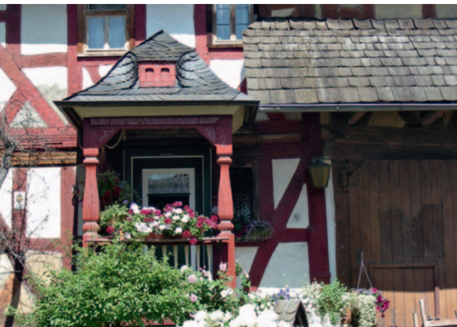
Ein später angesetzter Vorbau aus dem Historismus
