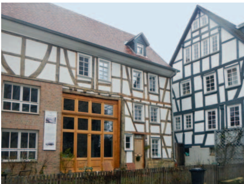
Umgebaute Scheune in der Wetterau
