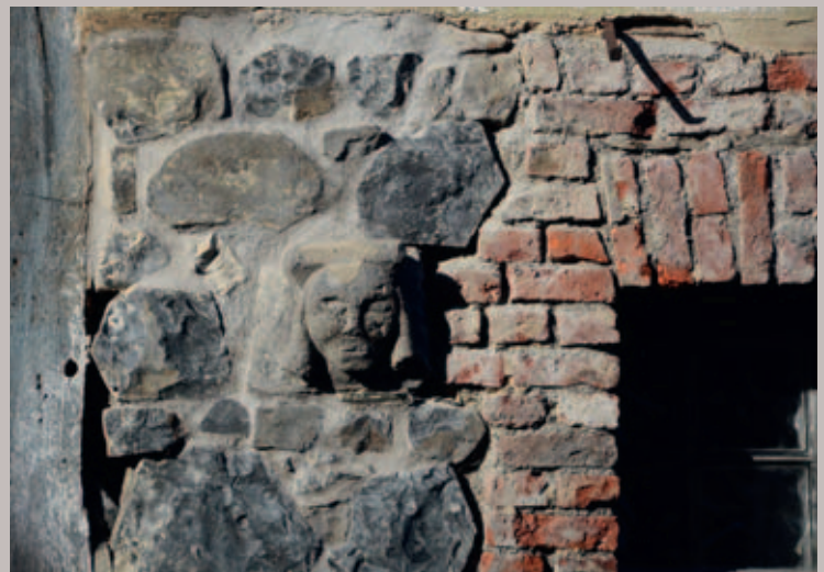
Greifenstein-Beilstein, Schalestein/Diabas mit Backsteingewände
