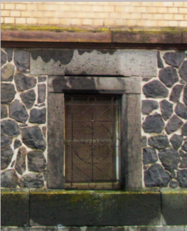
Natursteinsockel aus Basaltsäulen mit Tuffbasaltgewänden und -gesimsen
