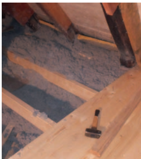
Aufdeckendämmung mit Nut und Federabdeckung.
