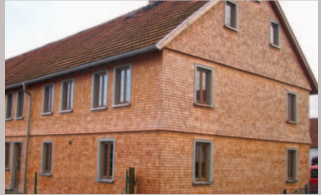
Lärchenholzschindeln an den Wetterseiten
