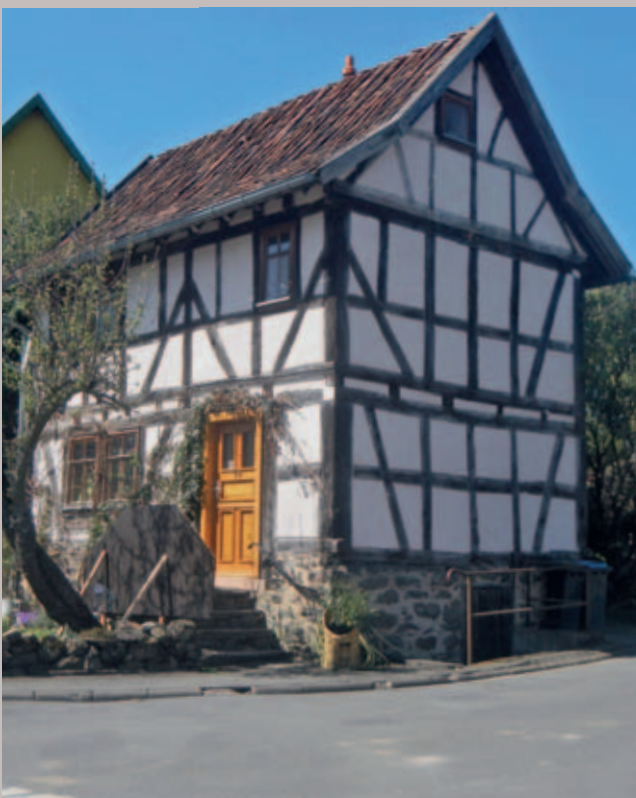
Kleines Hintersiedlerhaus im Schwalmthal
