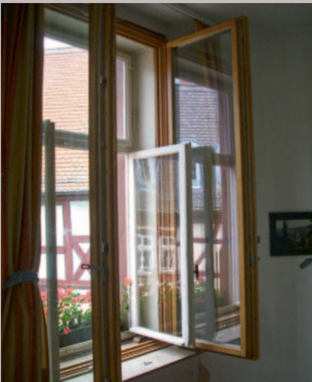
Stulp-Innenfenster hinter historischem Fenster
