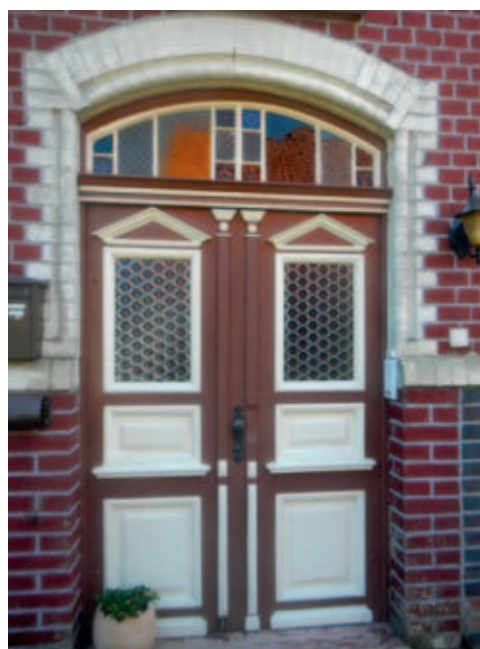
Wärmetechnisch verbesserte Tür aus dem Historismus
