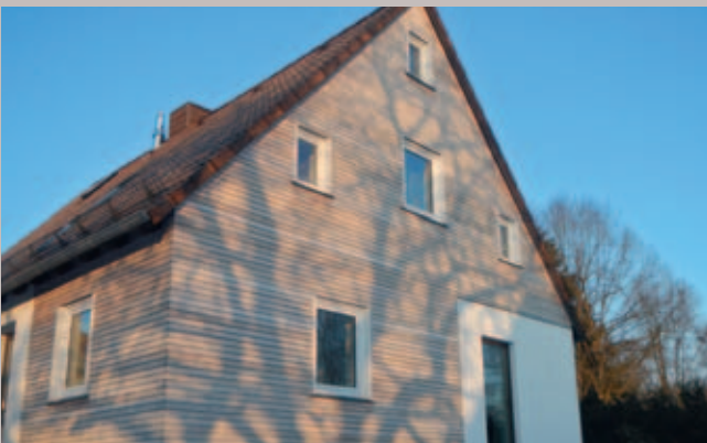
Horizontalschalung bei einem Haus aus den 1940er Jahren
