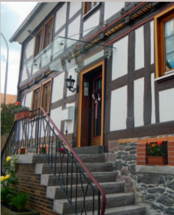
Modernes Glasdach an einer Fachwerkfront
