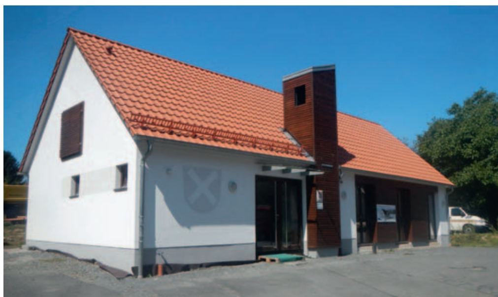
Neues Dorfgemeinschaftshaus mit Glockenturm im Kreis Darmstadt-Dieburg (Binder • Jarczyk • Architekten)
