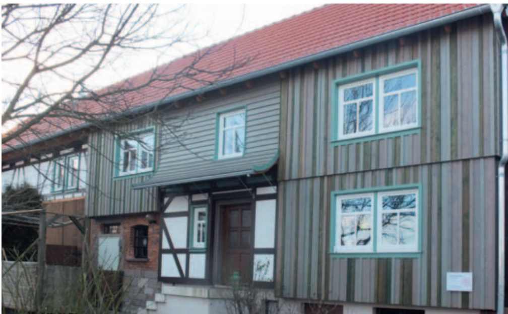
Größere Öffnungen zu Fensterpärchen umgebaut
