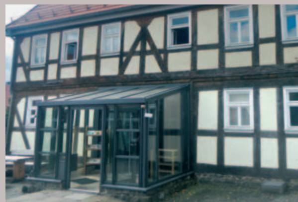
Schlichter Windfang an einem Kulturdenkmal in Hopfmannsfeld
