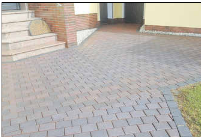
... und nach unserer Steinsanierung
