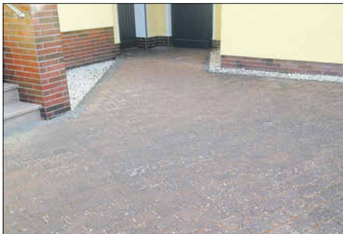
Die gepflasterte Fläche vor ...
