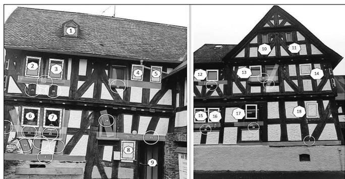
Positionenliste der Fenster und Balken für die Fassadensanierung
