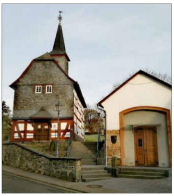
Die komplette Treppenanlage wurde abgetragen und neu aufgebaut, das Geländer durch ein ortsansässiges Unternehmen neu gefertigt und in seiner Höhe an aktuelle Anforderungen angepasst. Dabei wurde auch Altes erhalten. So hat man die geschwungenen Endungen des Handlaufs in das neue Geländer integriert. Im Zuge der Arbeiten wurde außerdem der erste Treppenabsatz bis zum Spritzenhaus gezogen, so dass hier nun eine größere, durchgängig gepflasterte Fläche entstanden ist.
